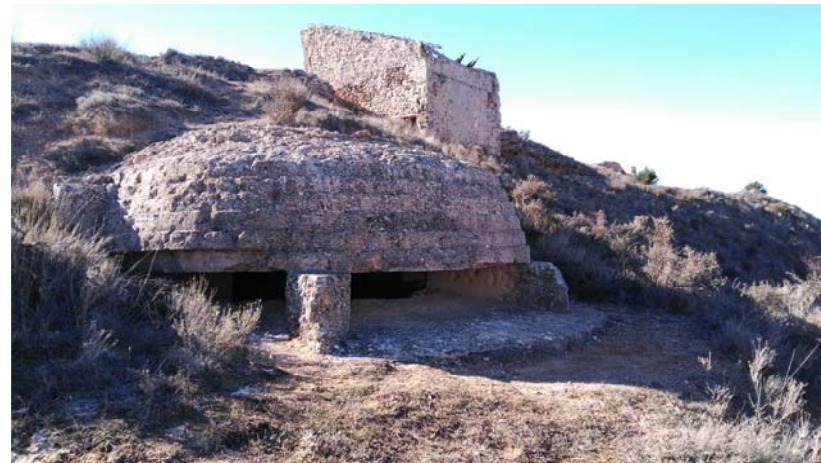
NIDO DE AMETRALLADORA
